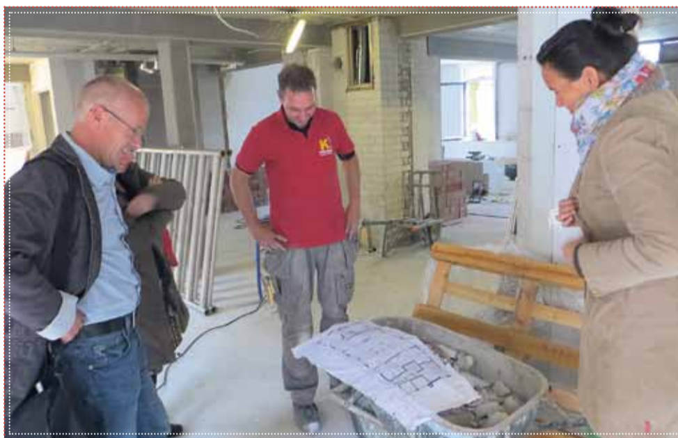
Rob, Christel, de aannemer en Wendo op de werkplaats
